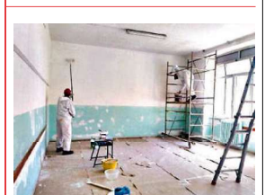
● Lavori in una scuola
